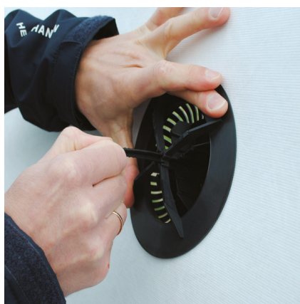
Dæksel trækkes stramt ned til undertaget
