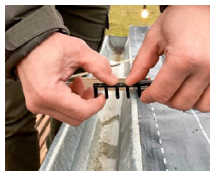
3. Tilpasning af fuglegitterbøjlen foretages ved at knække den eller klippe med en tang.
