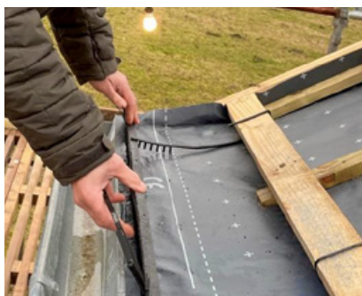
5. Hægt fuglegitterbøjlen på lægten og pres den runde monteringsdel ned i hullet på det ventilerede fuglegitter.
