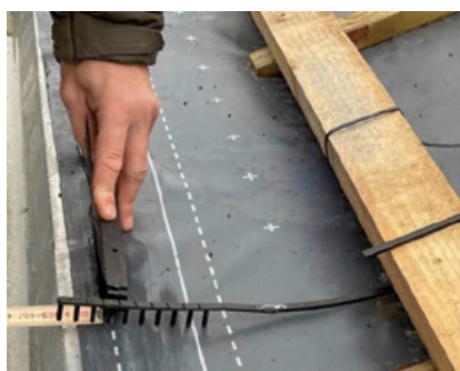
1. Hæng en fuglegitterbøjle på den nederste lægte.
