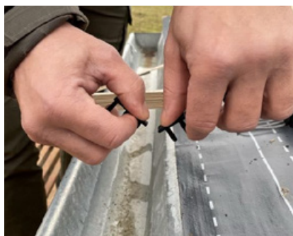
4. Knæk eller klip fuglegitterbøjlen af i den længde/det hak der passer.
