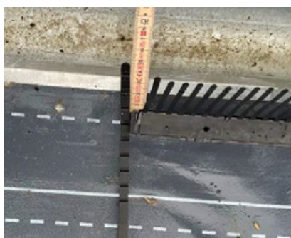
2. Det ventilerede fuglegitter skal placeres ca. 3-5 cm fra forkant fodblik. I viste eksempel skal bøjlen afkortes ved 3. markering.
