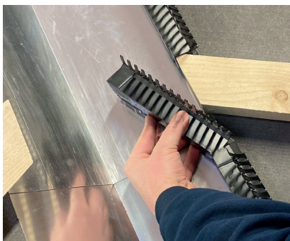
5. Evt. mellemrum dækkes ind med tildannet stykke element. Indsæt "laske" ved behov.
